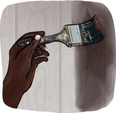
Proteja la madera de las termitas con aceite de motor o aceite de Neem, o utilice un marco metálico. Envuelva la parte inferior de los postes en plástico para evitar la entrada de termitas.
