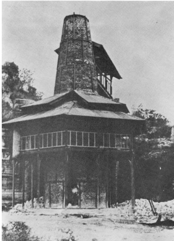
6 ton per day kiln in Bali.
