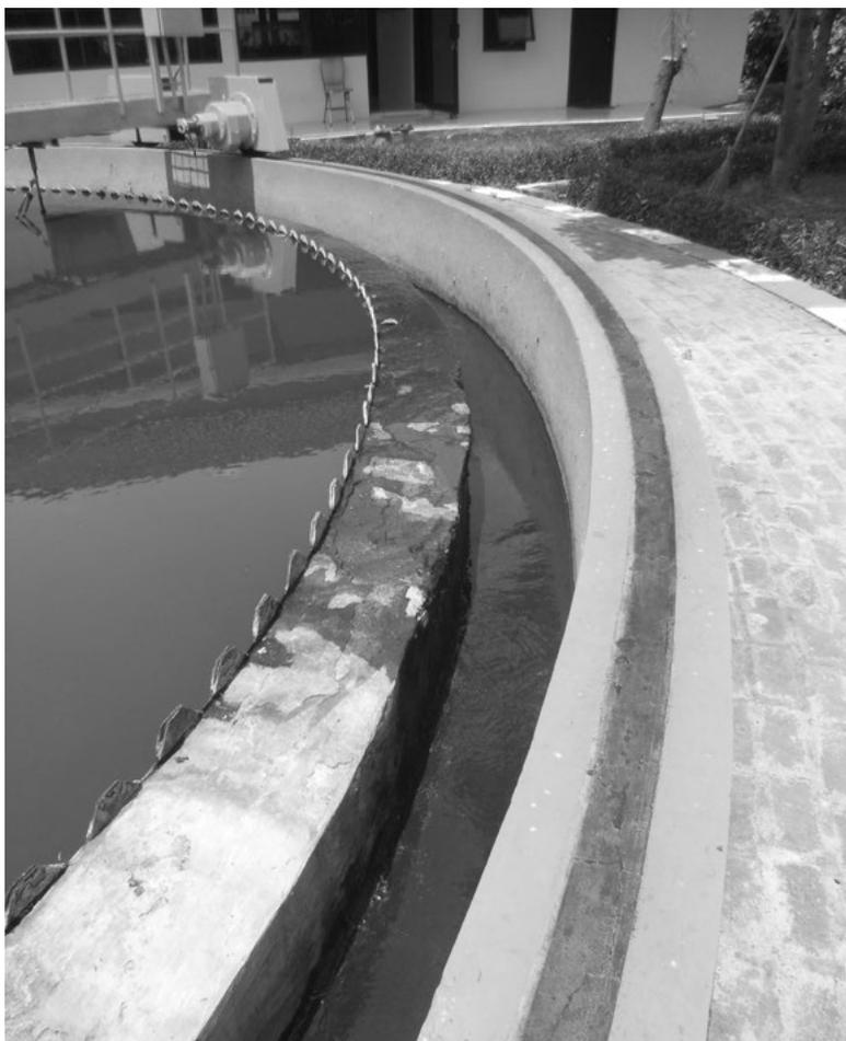
**Foto 5.5** Fluxo desequilibrado resultante do nivelamento incorreto do vertedouro
