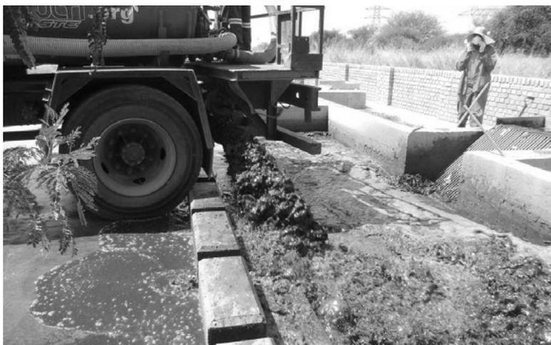
**Foto 6.3** Unidade receptora decantadora de base plana que pode ser melhorada por meio do ajuste dos níveis para que o decantador fique mais baixo que a via. Gaborone, Botsuana
