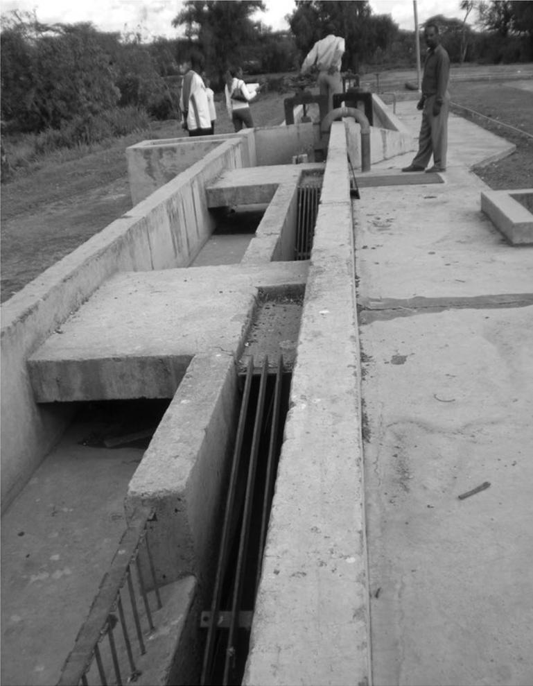
**Foto 5.3** Grade inclinada com acesso para o operador
