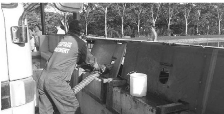
**Foto 6.4** Esquema de recebimento com tampa plástica articulada. Dumaguete, Filipinas
