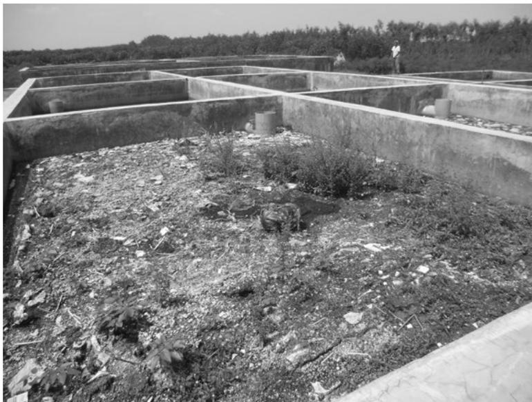
**Foto 5.1** Problemas no manejo de lodo em lagoa anaeróbia, em Tegal, na Indonésia (observe a falta de acesso do operador aos tanques)
