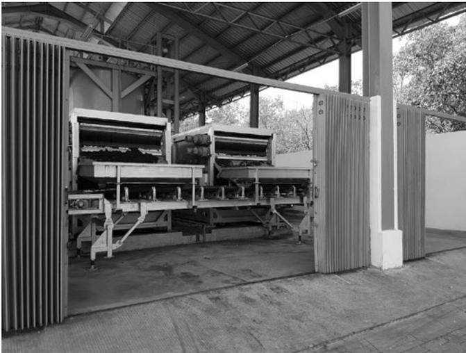
**Foto 7.4** Filtro prensa de esteira na estação de tratamento de lodo de fossa séptica de Duri Suwung, Denpasar, Indonésia
