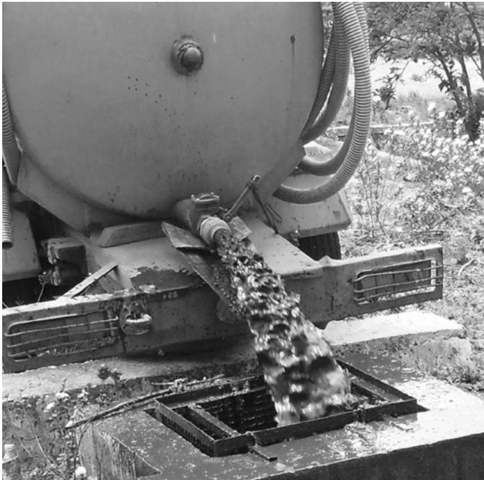
**Foto 6.1** Descarga direta para um tanque Imhoff: um esquema insatisfatório que provoca derramamentos
