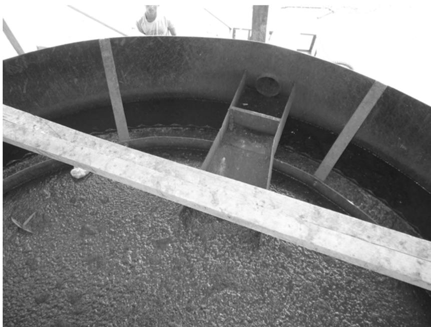
**Foto 7.2** Composição para remoção de espuma, tanque com fundo em tremonha, Sittwe
