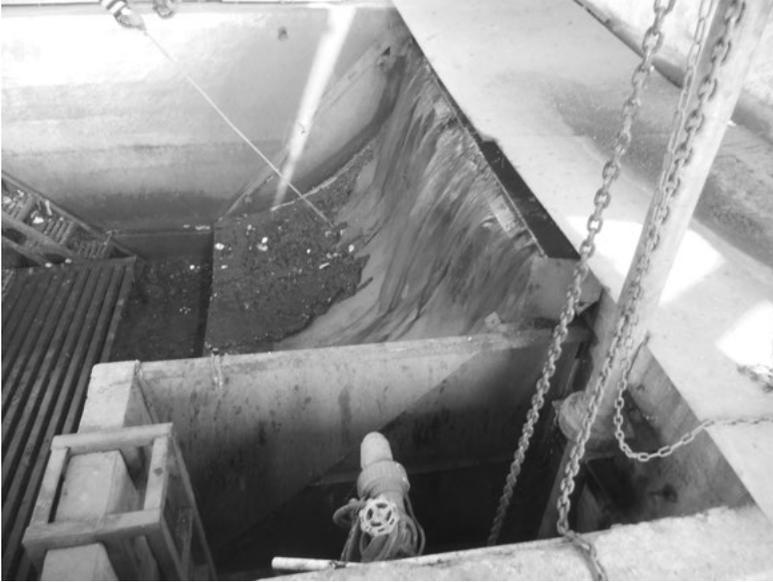
**Foto 6.7** Peneira estática na estação de tratamento de esgoto séptico de Pula Gebang
