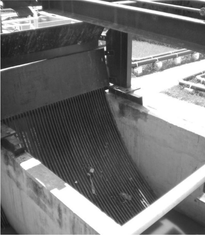
**Foto 6.6** Grade curva com mecanismo de limpeza giratório
