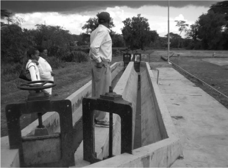
**Foto 6.9** Canal de partículas em uma estação de tratamento de esgoto em Naivasha, Quênia
