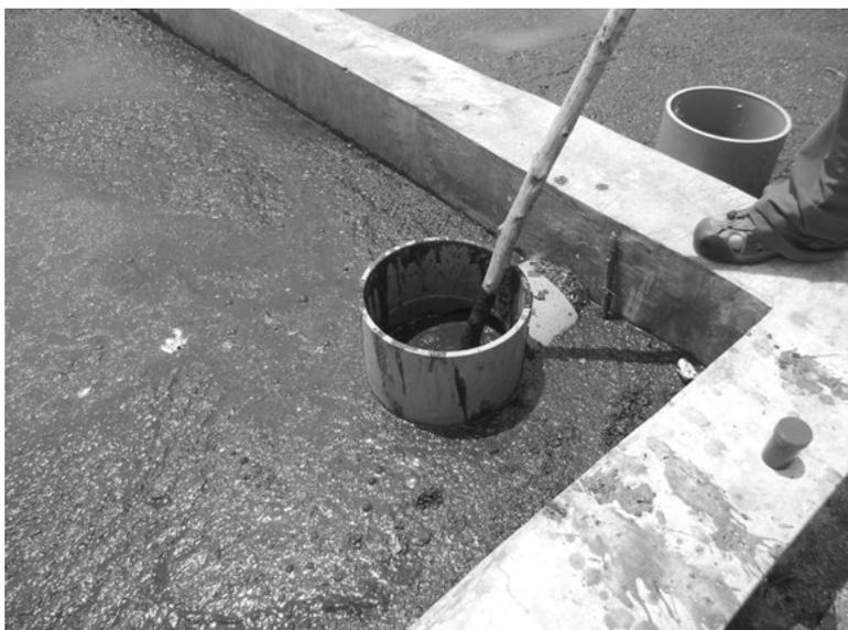
**Foto 5.4** Obstrução da tubulação de conexão
