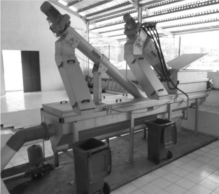
**Foto 6.8** Remoção mecânica combinada de detritos e partículas, em Jacarta
