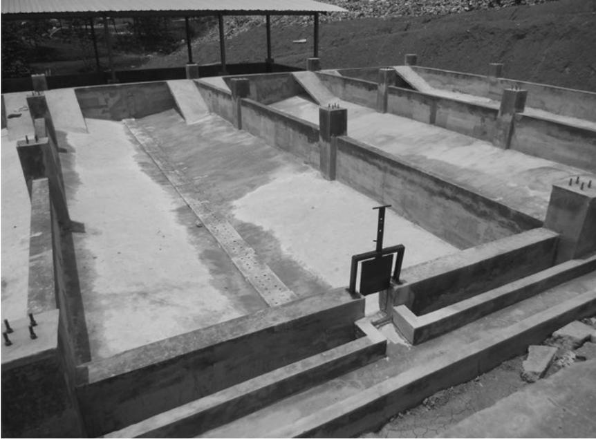
**Foto 9.1** Leitos de secagem em construção
