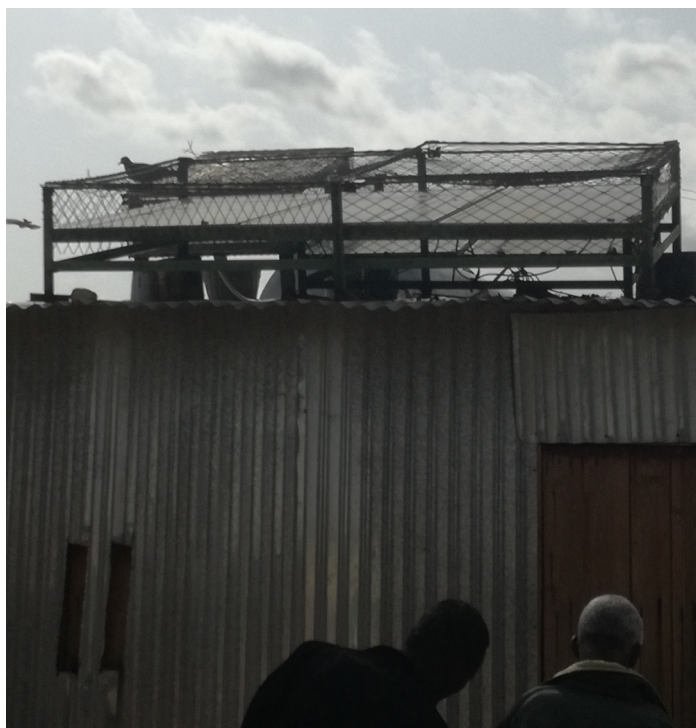
Figure 7.4 Mesures extrêmes de sécurité des modules à Burao, Somalie
