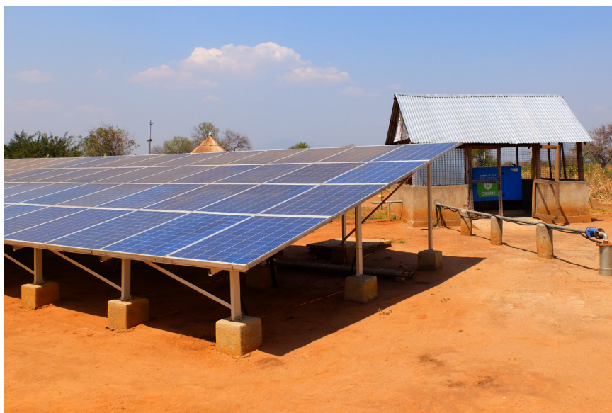
Figure 5.9 Système hybride solaire-générateur dans le camp de réfugiés d'Adjumani, Ouganda Source : Oxfam, 2016
