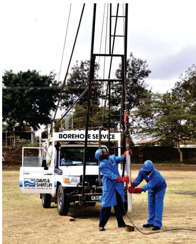
Figure 6.2 Installation d'une pompe à l'aide d'un treuil hydraulique
