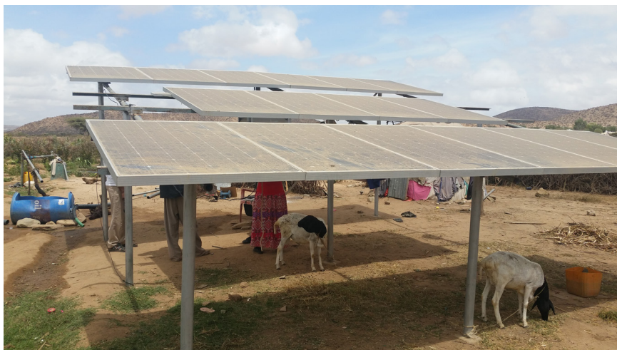
Figure 4.4 Sable sur les modules PV limitant la puissance de sortie
