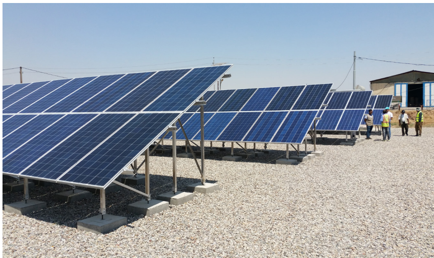
Figure 5.7 Modules PV à Sheikhan, Irak, orientés au sud avec une inclinaison de 36^\circ
