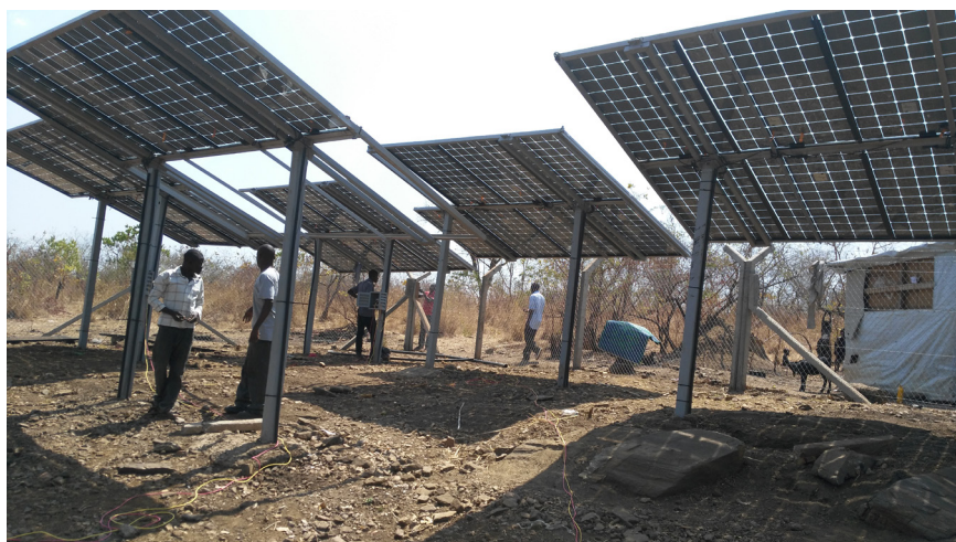
Figure 6.9 Modules PV fixés sur des mâts dans le camp de réfugiés de Bidibidi, Ouganda
