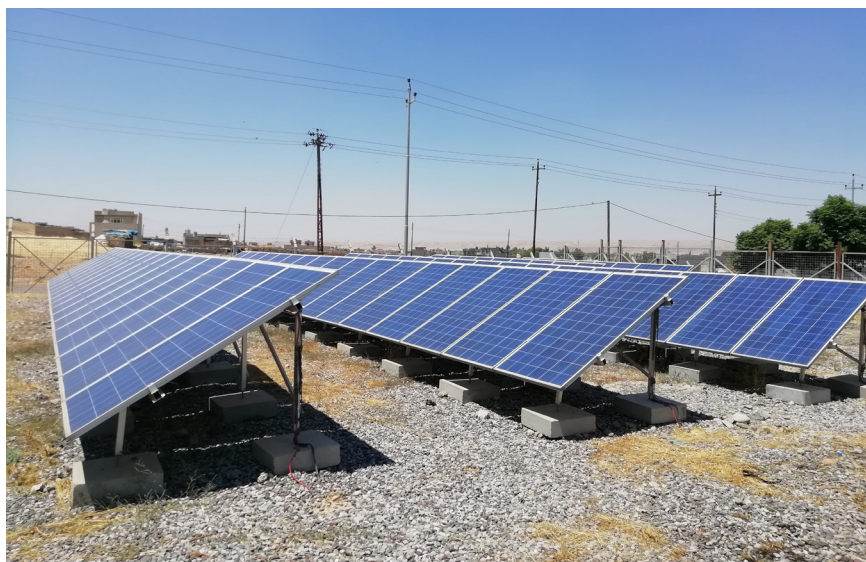
Figure 6.8 Structure fixée au sol dans le camp de réfugiés de Kawrogok
