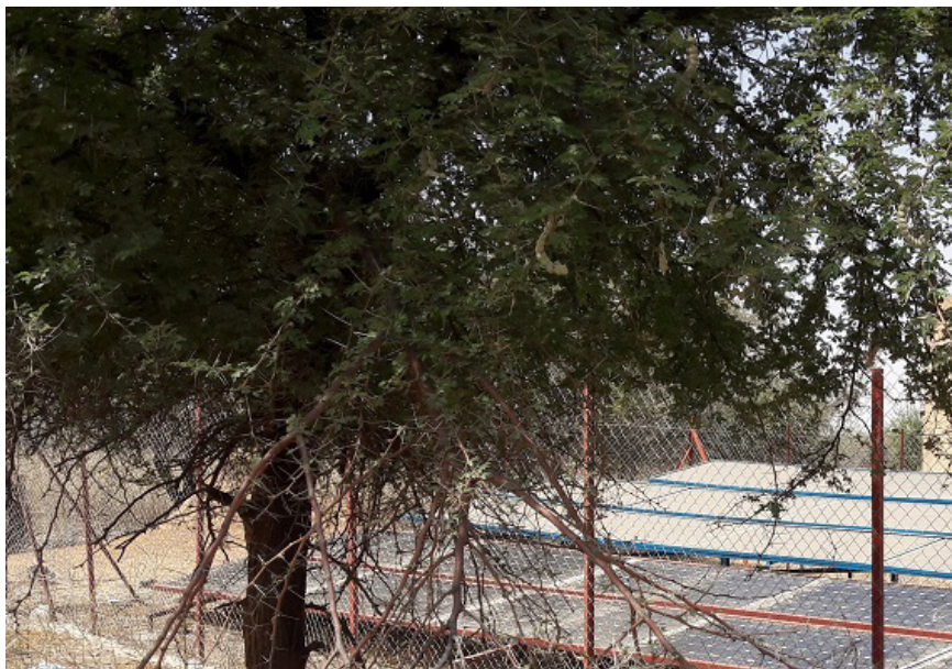
Figure 4.5 Ombre sur les modules PV limitant la puissance de sortie
