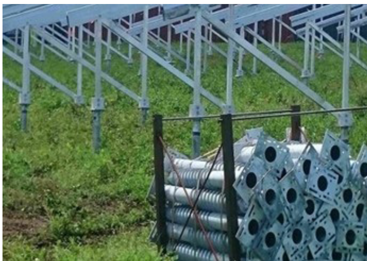
Figure 6.12 Exemple de structure sur pieux vissés
