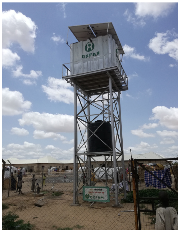
Figure 6.13 Structure installée sur un réservoir dans un camp de PDIP près de Maiduguri, Nigéria
