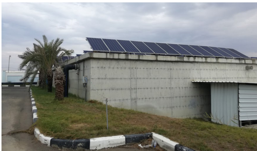
Figure 6.10 Modules fixés sur la toiture plane d'un réservoir à Gaza
