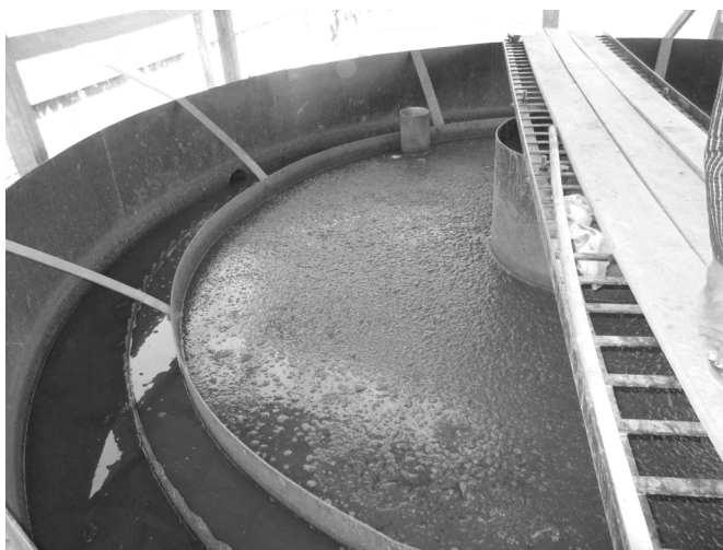
Foto 7.1 Espesador por gravedad con fondo tipo tolva en Sittwe (Myanmar)
