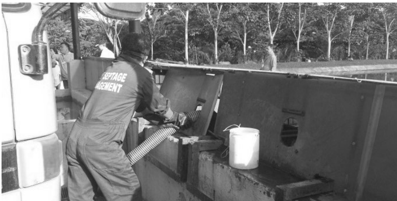
Foto 6.4 Zona de descarga con una cubierta protectora de plástico con bisagras, en Dumaguete (Filipinas)
