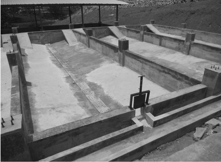
Foto 9.1 Lechos de secado en construcción
