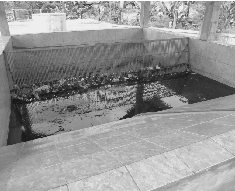
Foto 5.2 Rejas verticales sin acceso para el operador
