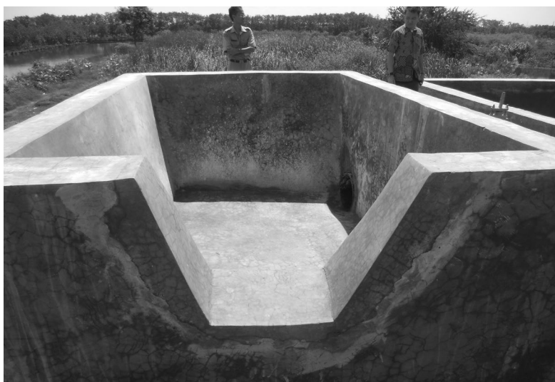
Foto 6.2 Cámara de recepción de lodos sépticos, Tegal (Indonesia)
