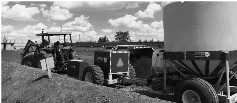
Foto 10.1 Instalación de compostaje en hileras de Sanergy en Nairobi
