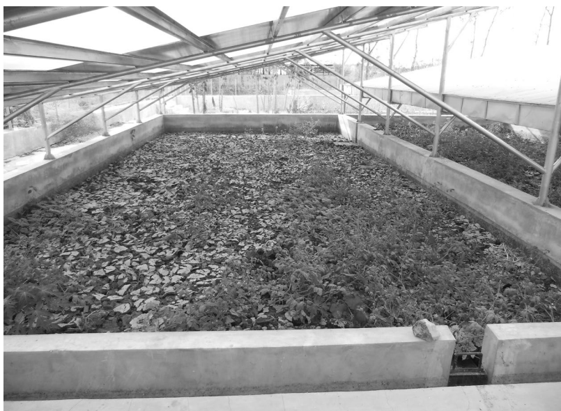
Foto 9.2 Arreglo de cubierta en un lecho de secado en Jombang (Indonesia)
