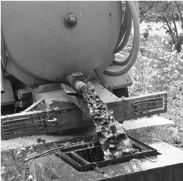
Foto 6.1 Descarga directa a un tanque Imhoff: no es una configuración satisfactoria pues resulta en derrames
