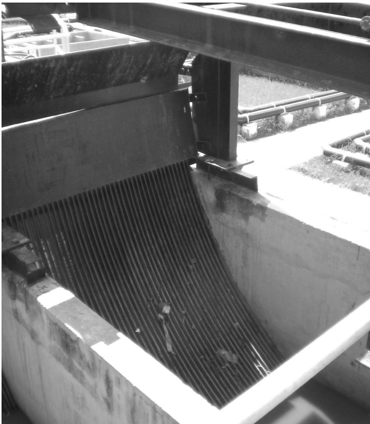
Foto 6.6 Reja curva con un mecanismo de rastrillado giratorio
