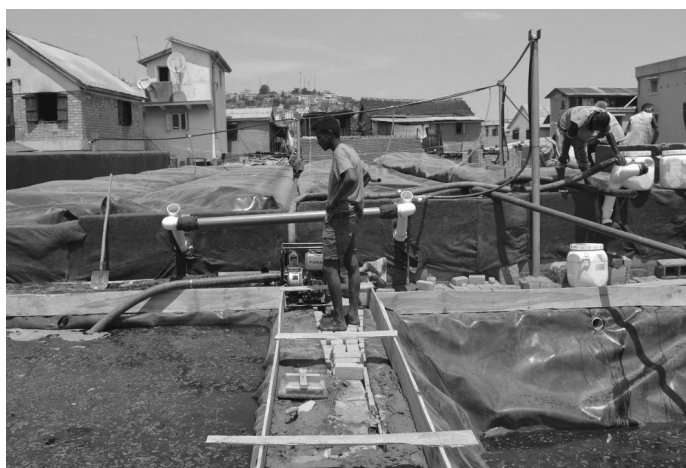
Foto 6.10 Digestor de bolsa de geotextil en Antananarivo (Madagascar)
