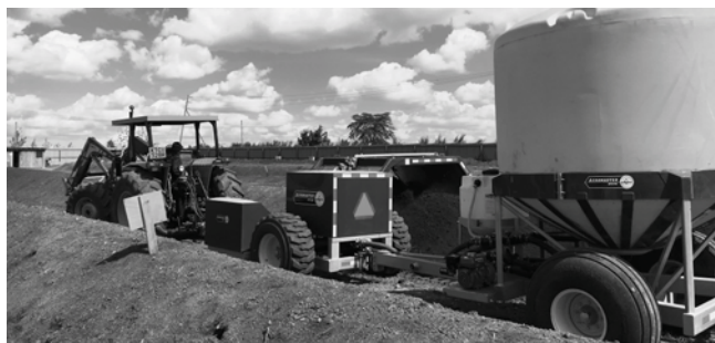
Photo 10.1 Installation de compostage d'andains Sanergy à Nairobi
