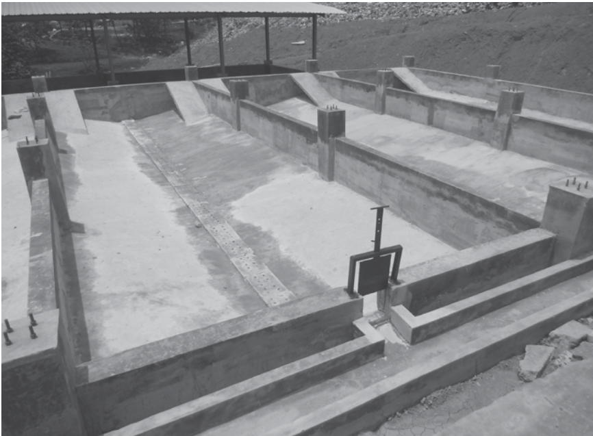
Photo 9.1 Lits de séchage en construction
