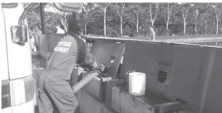
Photo 6.4 Zone de dépotage avec un couvercle de protection rabattable à Dumaguete (Philippines)
