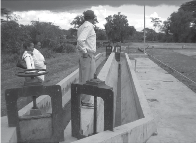
Photo 6.9 Canal de dessablage à la station d'épuration de Naivasha au Kenya
