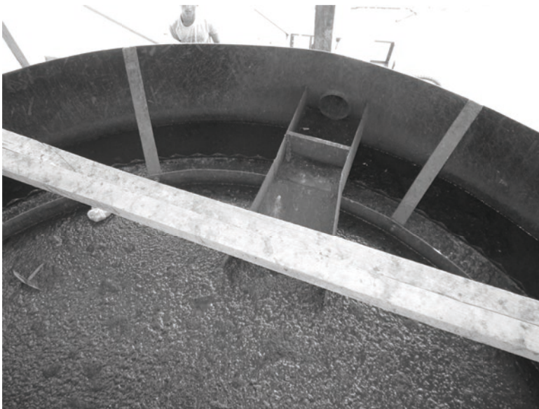
Photo 7.2 Dispositif de retrait de l'écume de l'épaisseur statique de Sittwe
