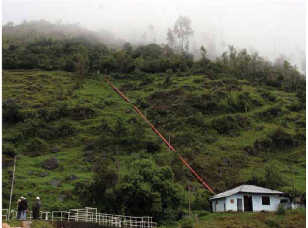
Microcentrale hydroélectrique de Conchán, Cajamarca, Pérou
